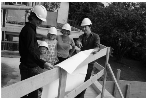
Abb. 12 Mit dem Energie-Coach auf der Baustelle.
