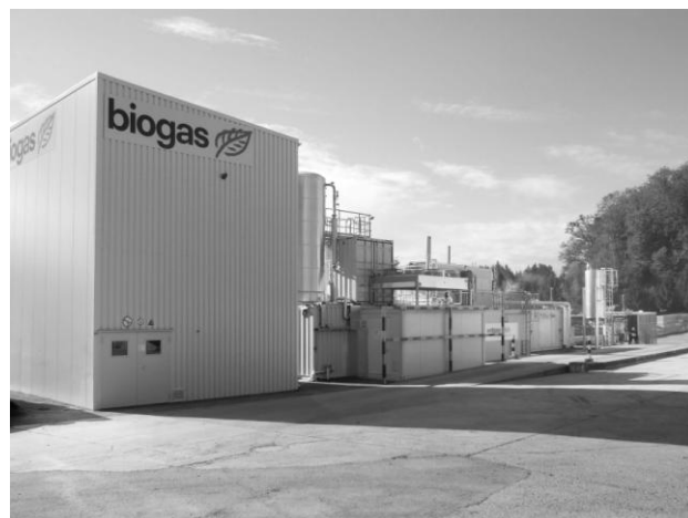
Abb. 6 Biogas-Anlage der Erdgas Zürich AG in Volketswil.
