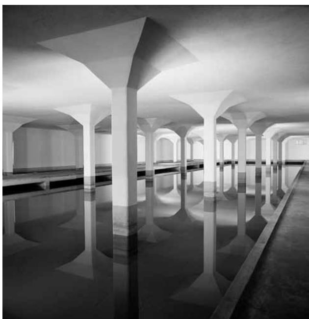
Das «Zürnwasser» besteht aus 70% Seewasser sowie je 15% Grund- und Quellwasser. Blick in den Langsamfilter im Seewasserwerk Lengg. (Bild: Wasserversorgung)
