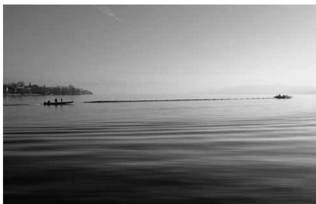
Bau der Seewasserleitung für den Energieverbund im Zürcher Seebecken. (Bild: ewz)
