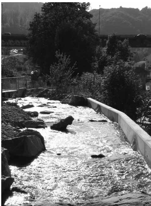
Fischpass des Kraftwerks Wettingen. (Bild: ewz)
