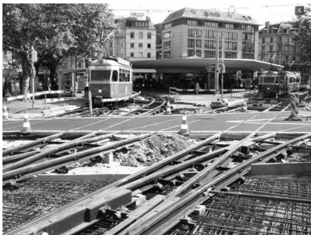
Trotz Gleisbauarbeiten am Bellevue konnten die meisten Tramlinien auf normalen Strecken verkehren. (Bild: VBZ)
