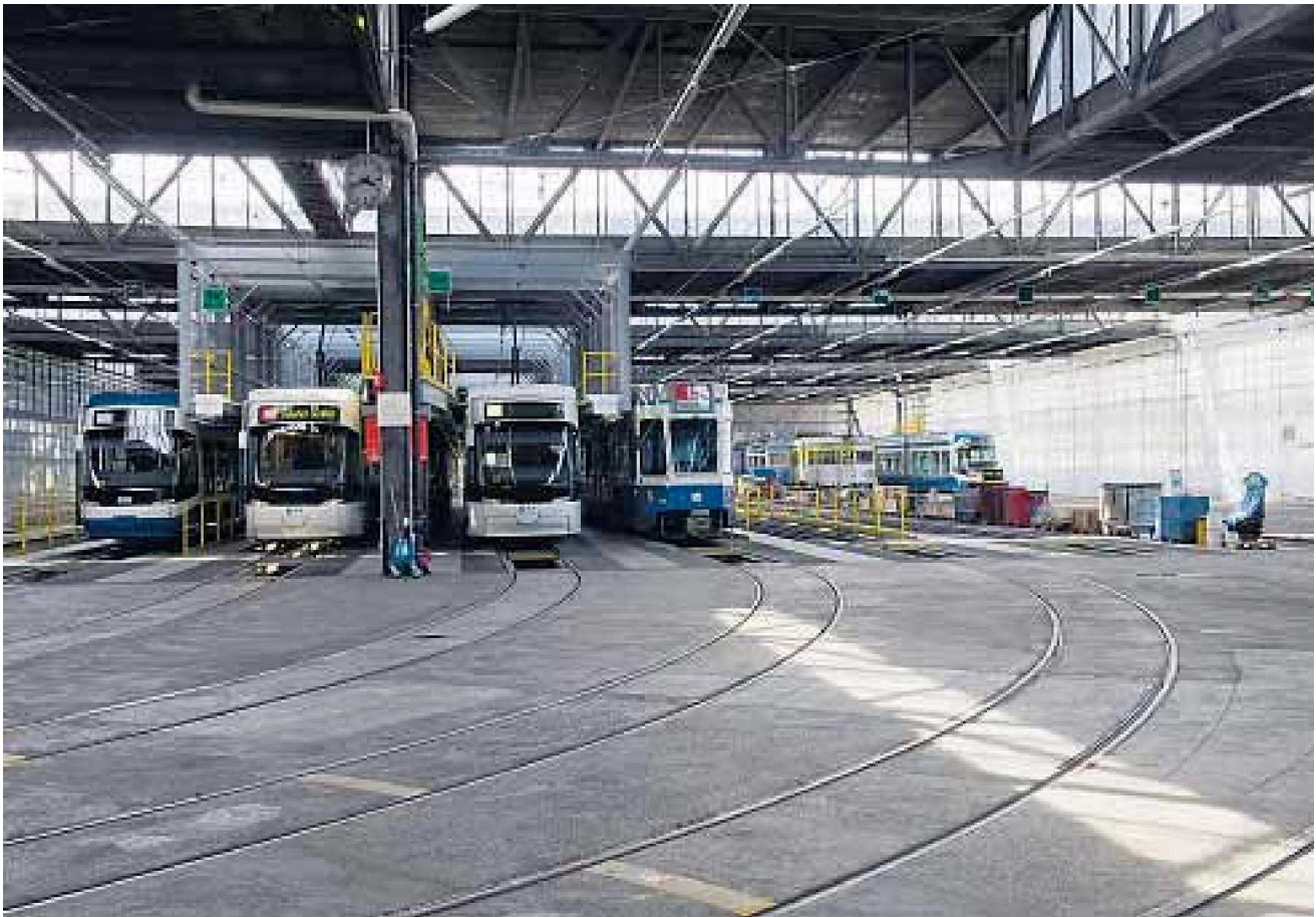
Das Tram-Depot Oerlikon wird derzeit für Cobra-Trams der Glattalbahn erweitert.
