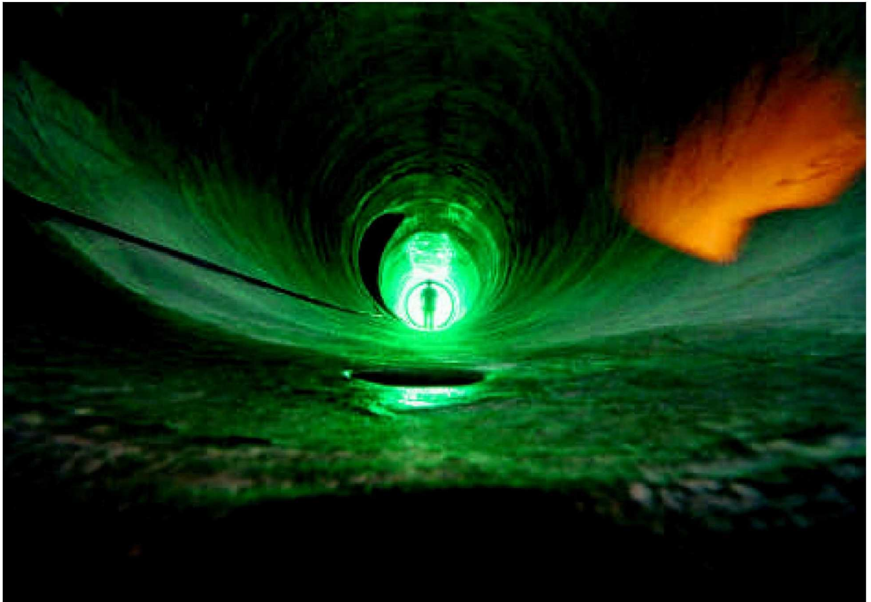
Blick aus dem Trinkwasserstollen Üetliberg beim Seewasserwerk Moos in Zürich.
